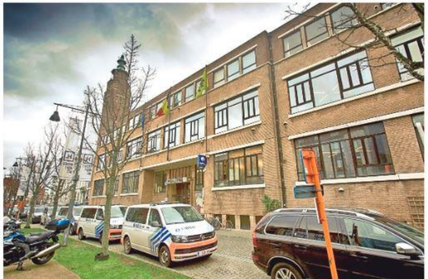
De gebouwen van het Administratief centrum en het politiebureau worden gesloopt voor nieuwe woonprojecten. Foto Tony Van Galen
